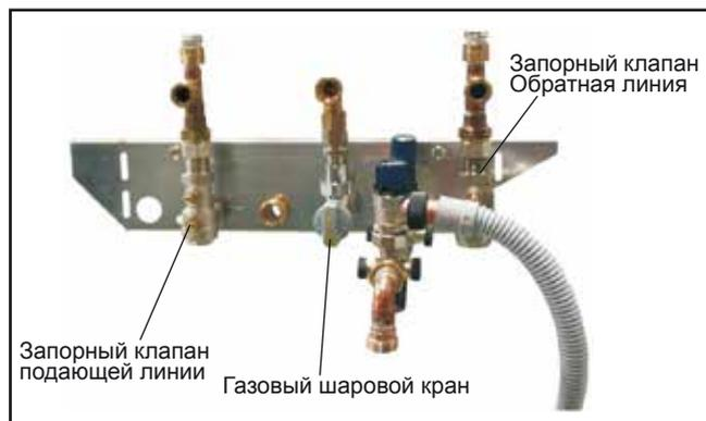
Рисунок: Запорные устройства на консоли для стен без отделки для скрытого монтажа (дополнительное оборудование)
